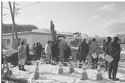
建設中の西町団地現地視察
