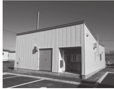
緑町熱供給施設 (ボイラー室)
