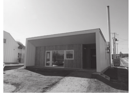
緑町熱供給施設（多目的ルーム）
