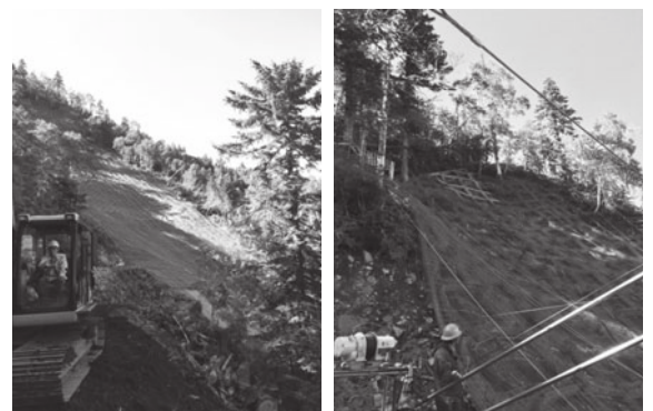
道道屈斜路津別線復旧の様子
