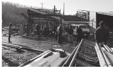
相富木材加工(株)再建現場の現地視察
