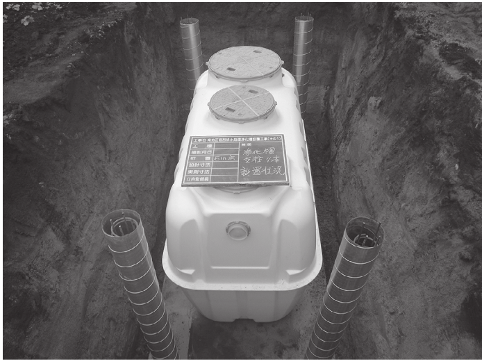
平成29年6月 個別排水浄化槽設置状況
