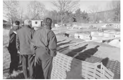
相生総合交流ターミナル合併 浄化槽等設置工事の現地視察
