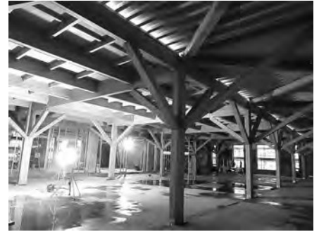
役場新庁舎1階の建設現場
