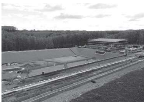
建設が進んでいる一般廃棄物最終処分場
