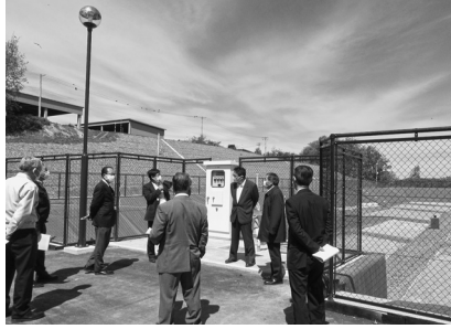
完成した一般廃棄物最終処分場の 現地視察 (6/2)
