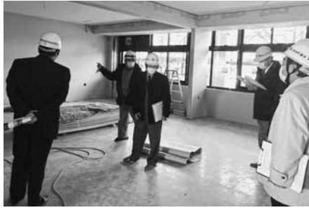
津別小学校旧校舎長寿命化改修工事現場の現地視察(11/2)
