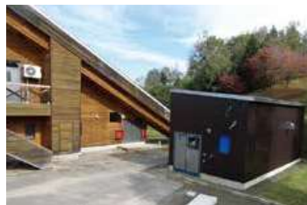
木材工芸館木質バイオマスボイラー施設建設工事現場
