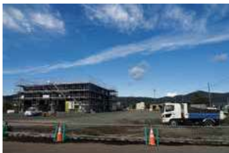
木質バイオマスセンター建設工事現場
