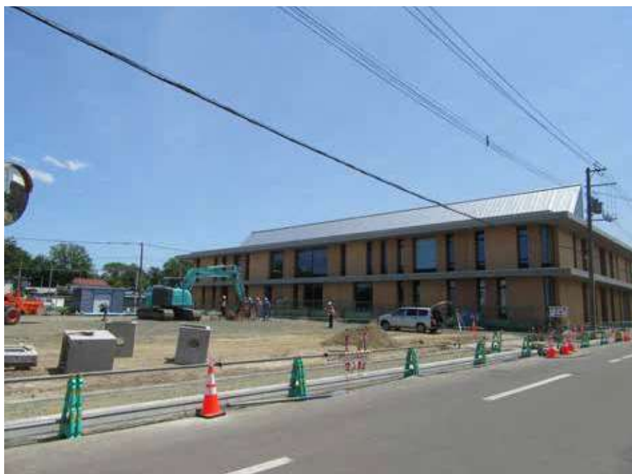
役場庁舎正面駐車場外構工事現場
