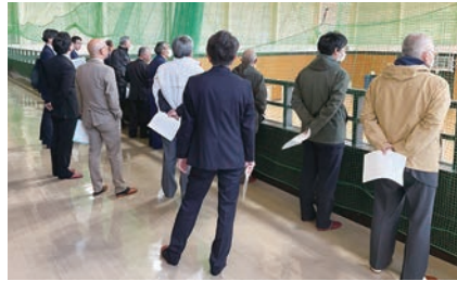
トレーニングセンターアリーナ床 改修工事現場の現地視察（11/5）
