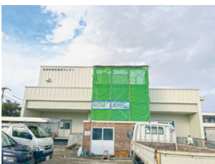
給食センター建設工事現場
