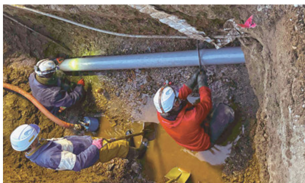
水道管修繕工事
