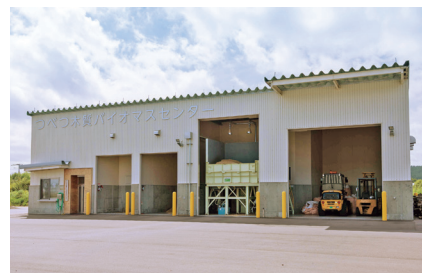
津別町木質バイオマスセンター
