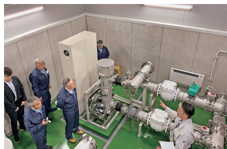
上里浄水場紫外線滅菌装置設置 工事個所の現地視察（6/5）
